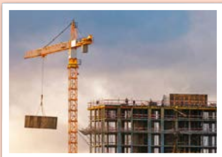
Obr. 5 – Jeřáb zvedající náklad
